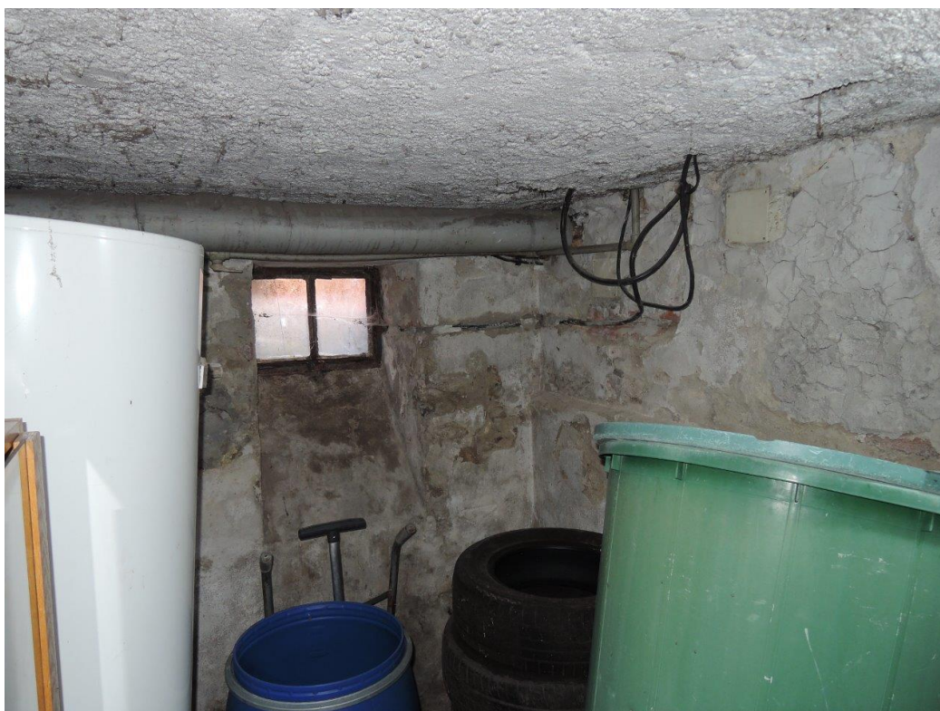
Foto č. 8 – Sklep – plíseň na zdivu, opadaná omítka
