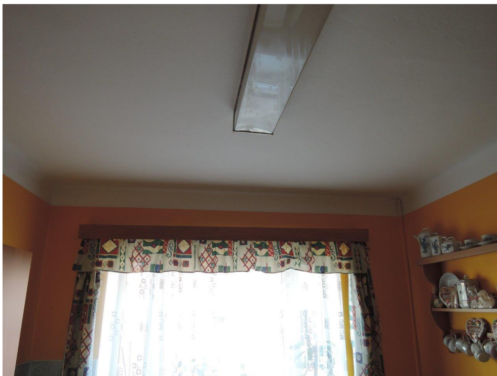
Foto č. 10 – Přizemí – rákosový podhled – drobné trhliny
